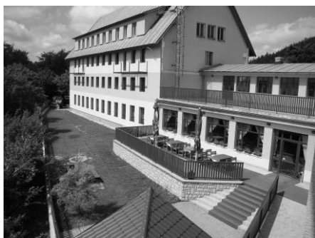
Ubytovanie v zrekonštruovanom hoteli, ktorý nesie meno Vršatec
